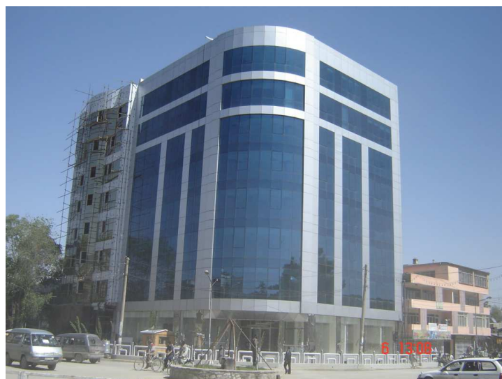
ساختمان جدیدی در شهر نو
